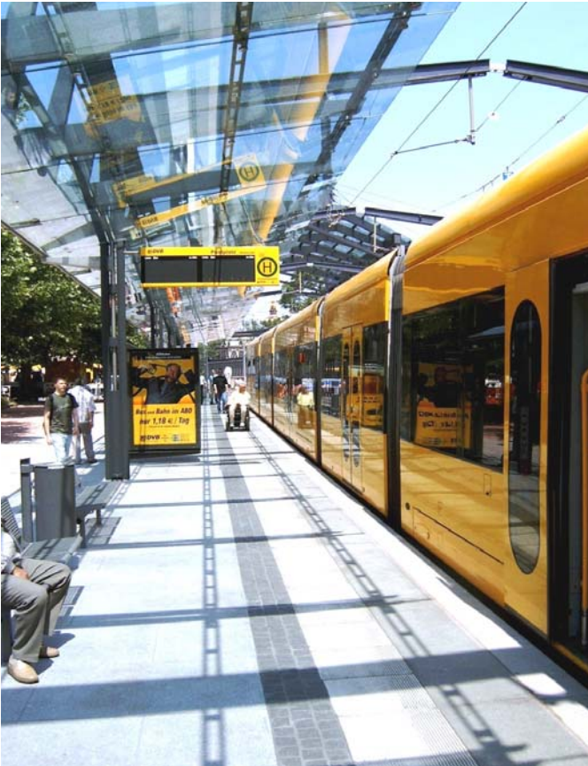
Barrierefreie Haltestelle für Straßenbahn und Bus – Dresden-Postplatz
